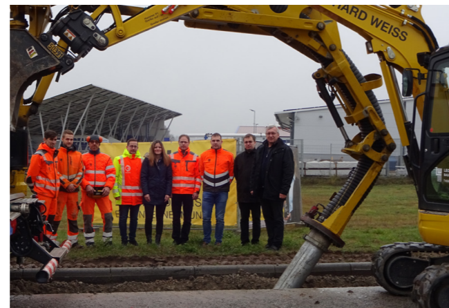
Breitbandausbau Spatenstich im Gewerbegebiet Bergbronn (Dezember 2018)
