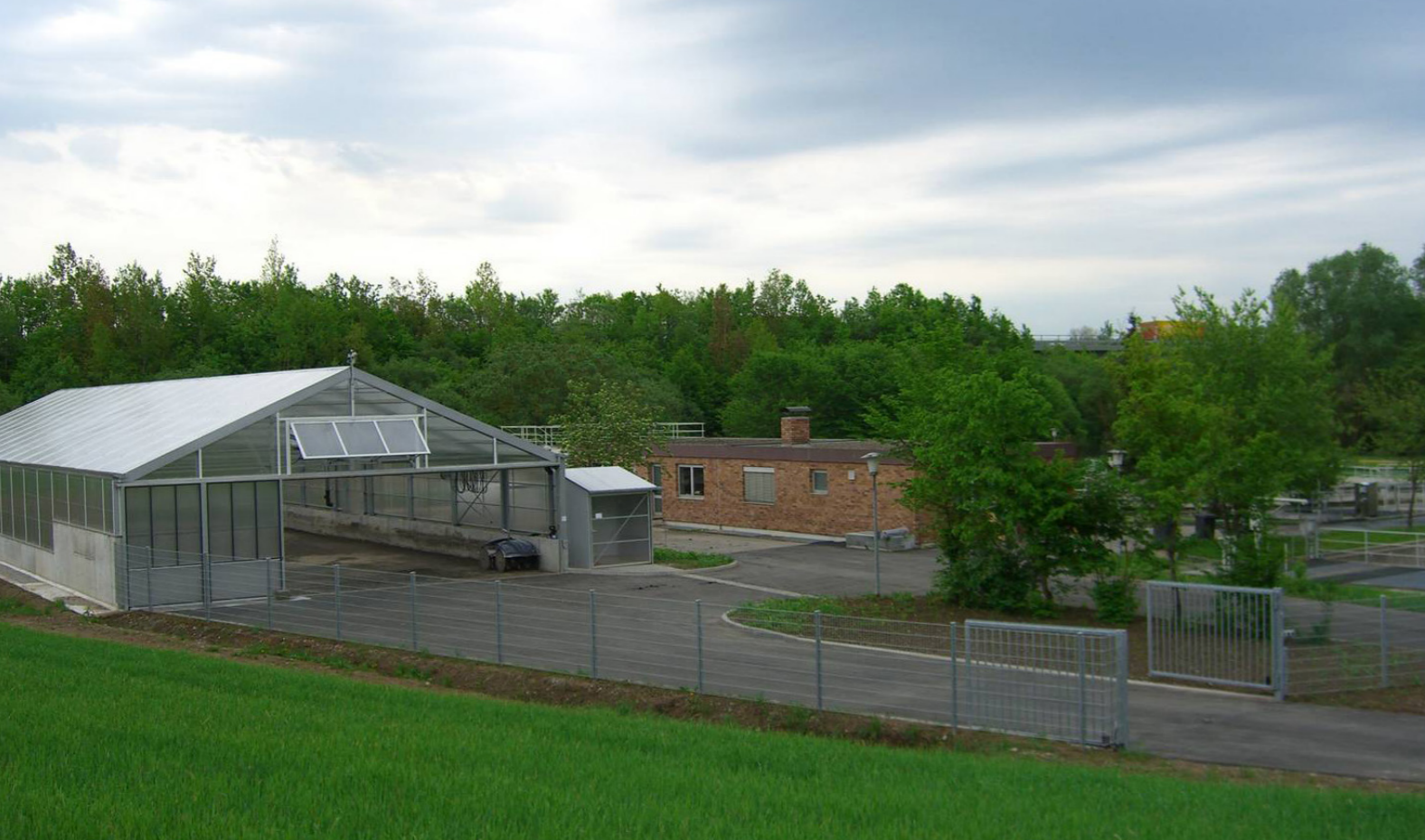
Solare Klärschlamm-trocknungshalle (Baujahr 2005)
